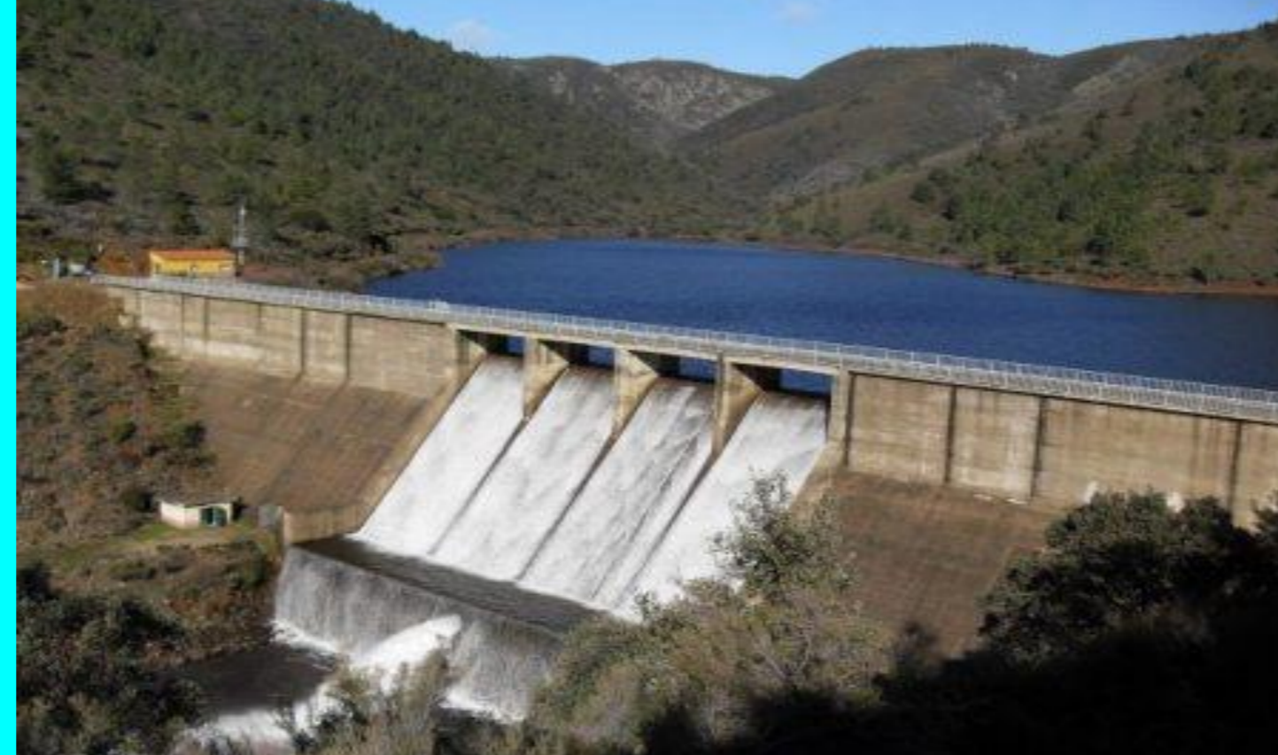
- Presa de gravedad
