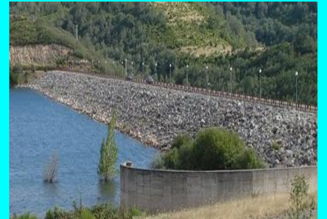
- Presa de materiales sueltos
